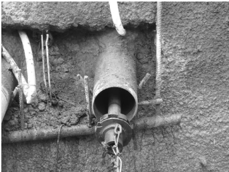
图 10 管棚中的探棒
